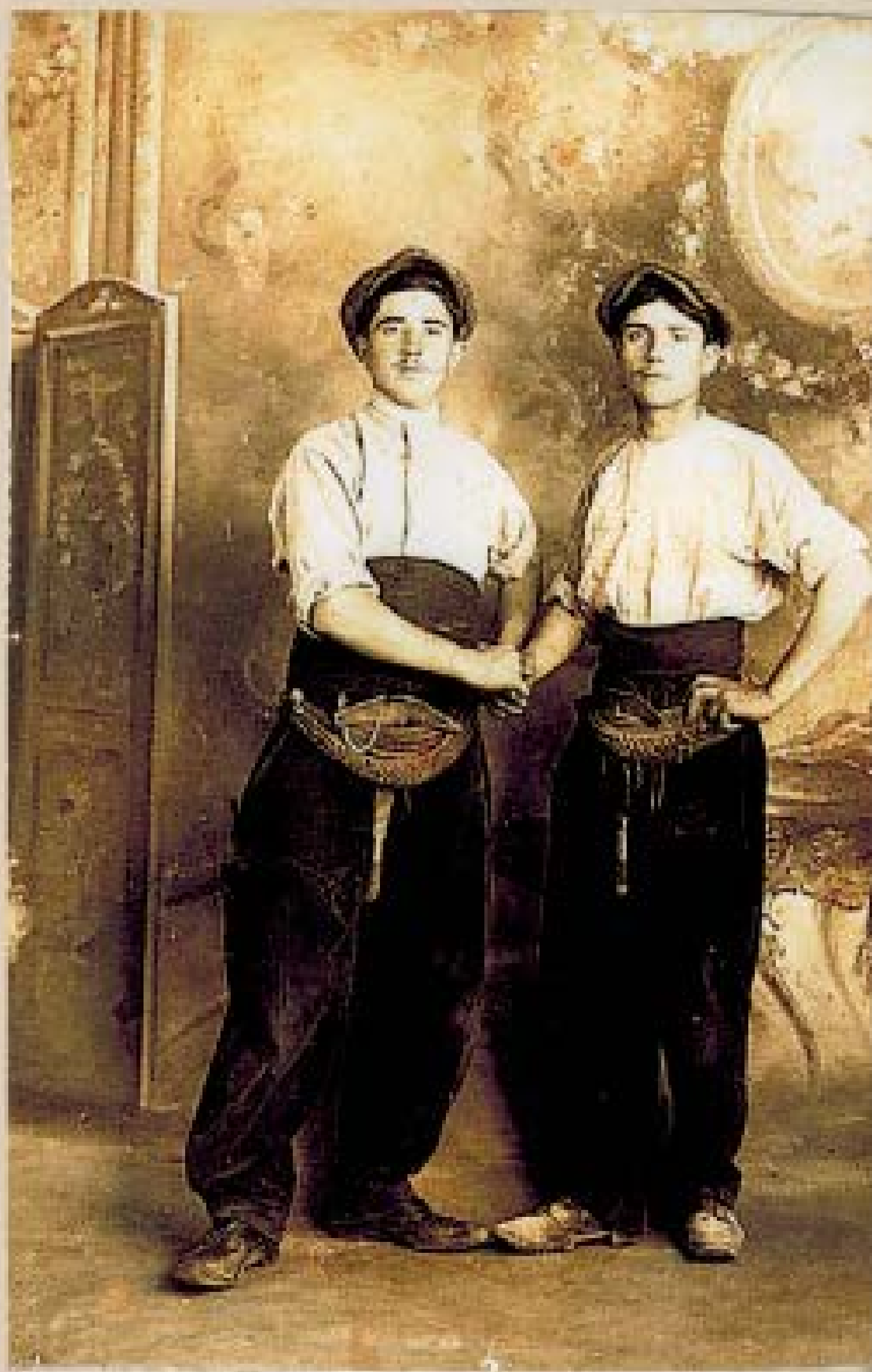
Deux compagnons charpentiers en l'air.
